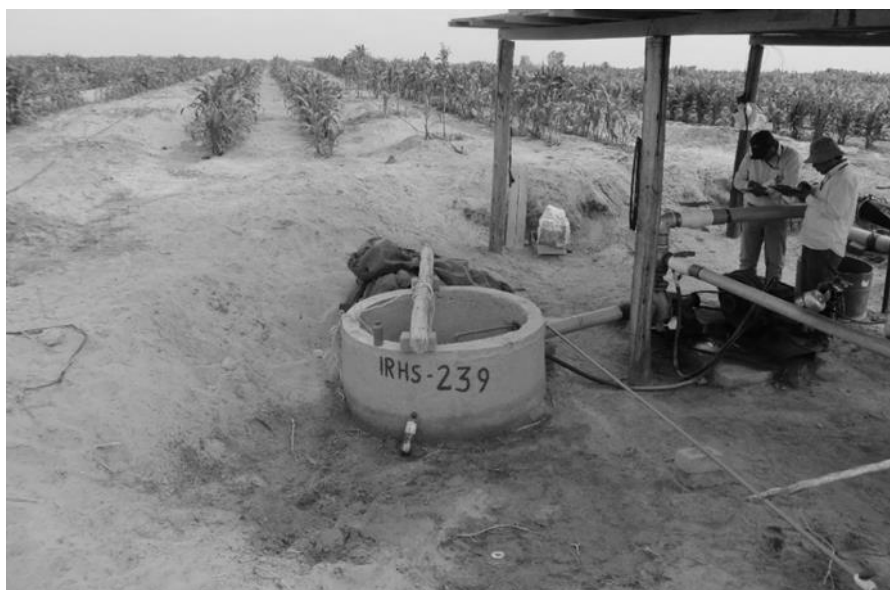
Imagen 4. Pozo tajo abierto de concreto
